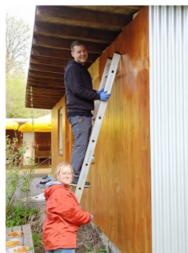
Mit vollem Elan machen sich die Pfadfinder an die Renovierung.
