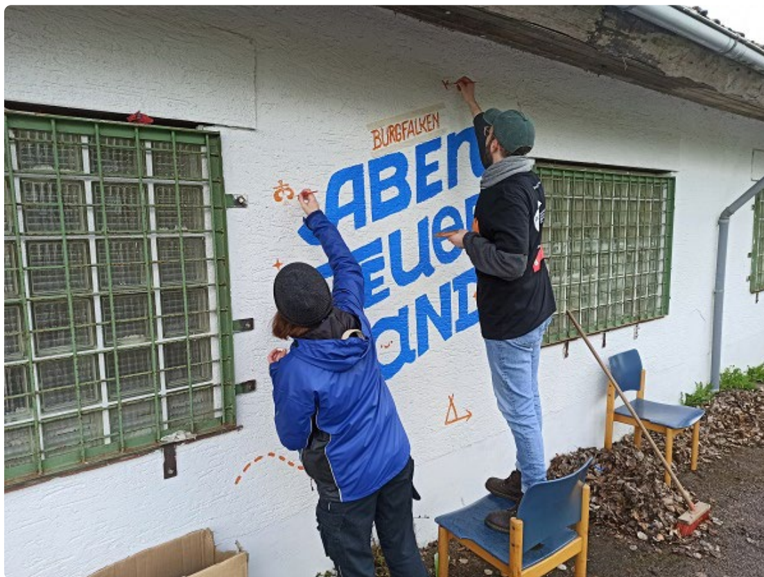
Gebäude, die bereits in die Jahre gekommen waren, werden instandgesetzt.
